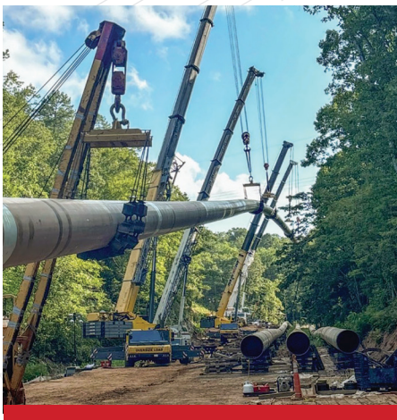
Protección mecánica y anticorrosiva.
