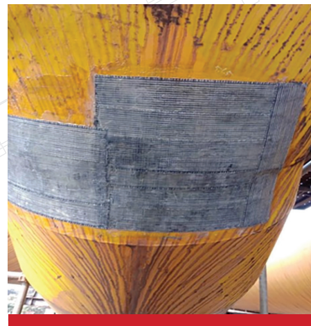
Reparación de ductos con materiales compuestos en una planta siderúrgica.
