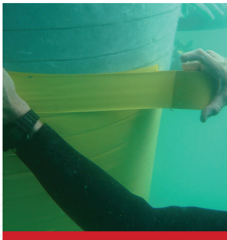
Preparación mínima de la superficie y adhesión inmediata con los sistemas STOPAQ .
