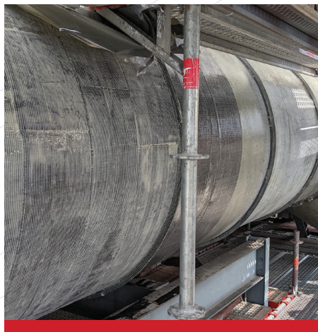
Reparación de ductos con materiales compuestos en una planta de gas natural.
