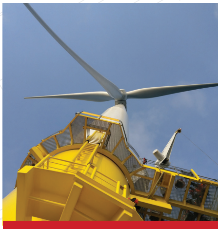
Protección anticorrosiva de una turbina eólica.
