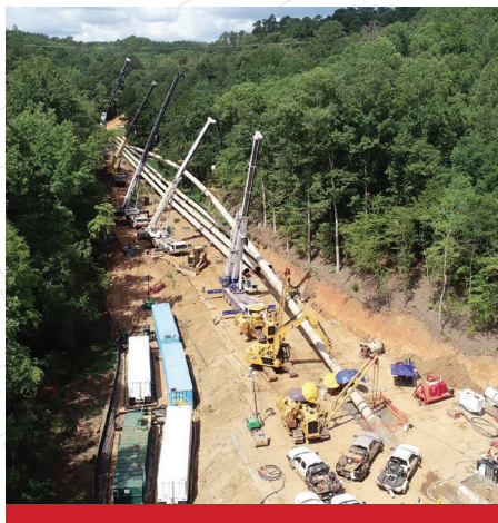
Instalación de ductos sin zanja.
